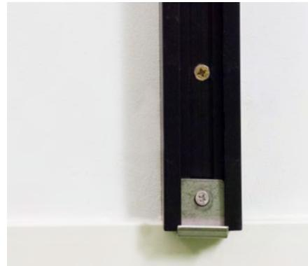
Una vez tenemos los rastreles colocados, fijamos clip de inicio, que se encarga de sujetar la primera lama de Annapurna
