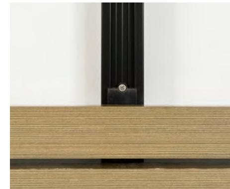
Llegados a la fila 10, volveríamos a colocar tornillo de fijación para garantizar la horizontal. Repetimos proceso hasta finalizar.
